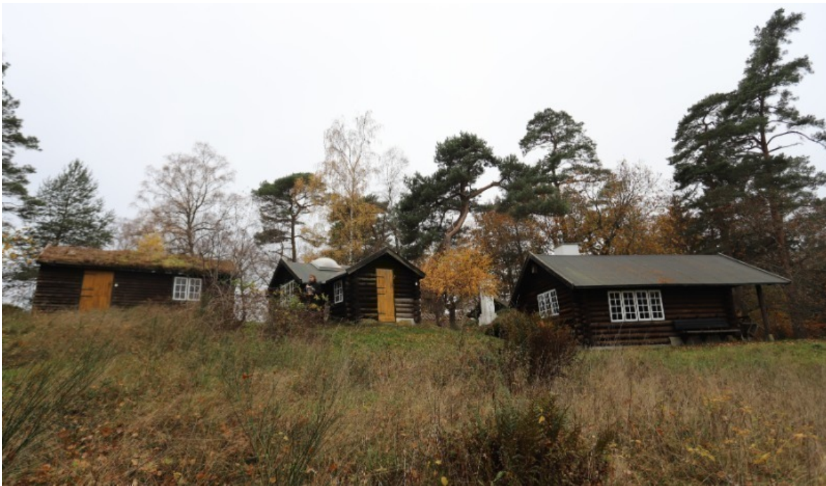
Eksisterende forhold, set fra Øst
