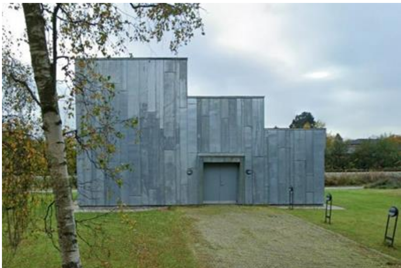
Billedet viser pumpestationen på Haarlands Allé, matr.nr. 4ho, Tisvilde By, Tibirke, som elkedlen skal placeres i.
